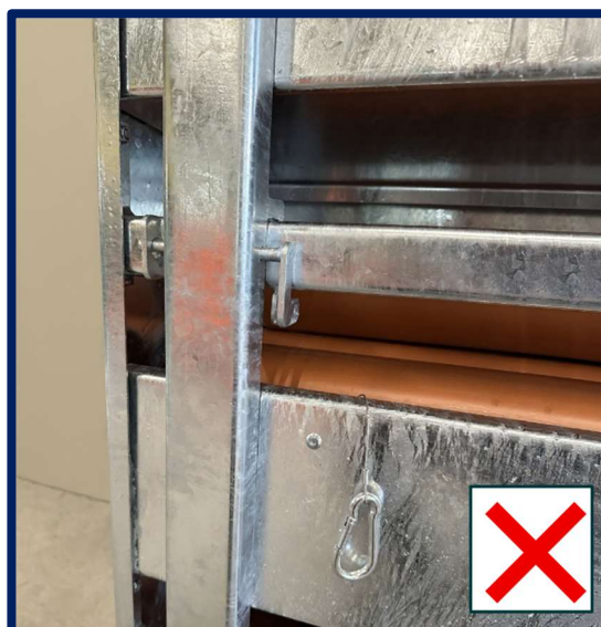
Utilstrækkelig sikring af lås
